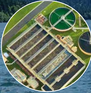
Atıksu Arıtma Sistemleri
